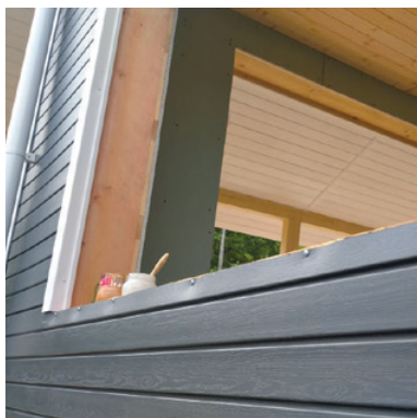
Нет окон, металлического отлива, саморезы вкручены в тело панели сайдинга. Подрезанная панель с предварительно сделанными насечками должна фиксироваться в финишной планке.
